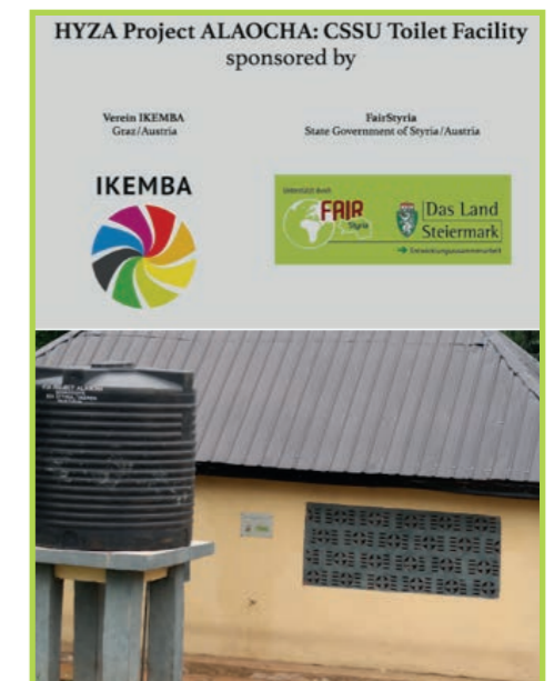
Foto: Saubere Sanitäranlagen im gelben Gebäude. Links steht der Wassertank, welcher mit Wasser aus dem Projekt „Wasser ist Zukunft für Alaocha – WaZA“ versorgt wird. Oben im Bild: Fördergeber des Projekts © IKEMBA
